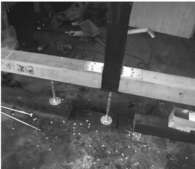
玉石基礎部分の基礎工法。土台を設置し鋼製束で水平調整、柱下部を切断後配筋・打設。
