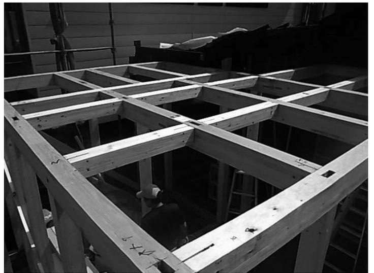
小屋裏収納の床を剛床とし、水平構面をつくる。
