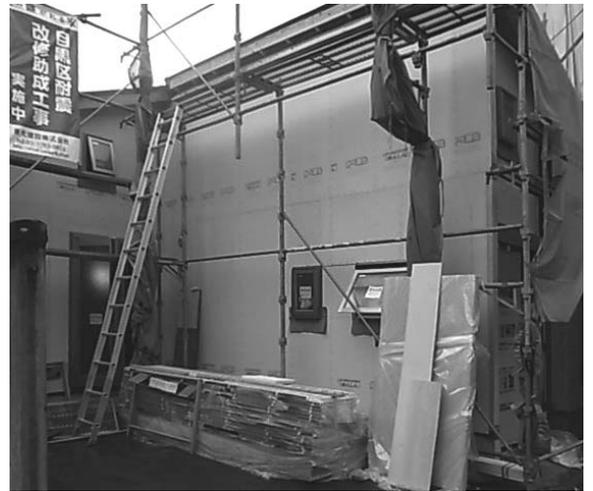
外壁耐震補強:パルプ・けい酸質セメント板厚9。
