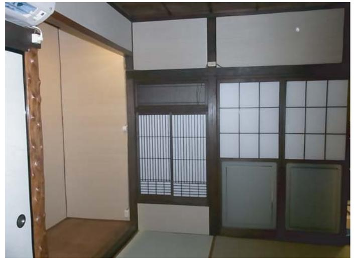
**旧居間** 変色した柱・なげしはOS塗装し、壁は布クロス貼り。
